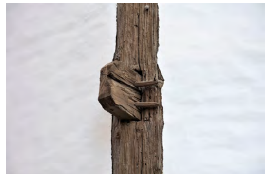
Die Deckenbalken sind eingezapft
