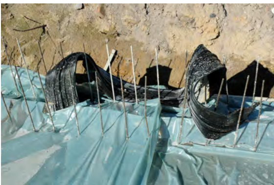
Lagerung von Fugenband
