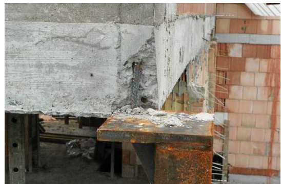
Deckenauflager auf einer Stahlstütze
